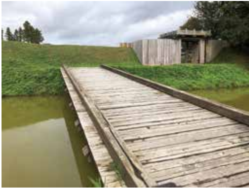
越後和田氏の居館「江上館」 (新潟県胎内市)
